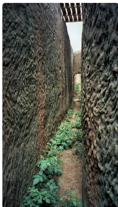
Wykuty w piaskowcu kanał rzymskiego akweduktu z czasów Tyberiusza Fot. Rowanwindwhistler, CC BY-SA 3.0 , Wikimedia Commons
