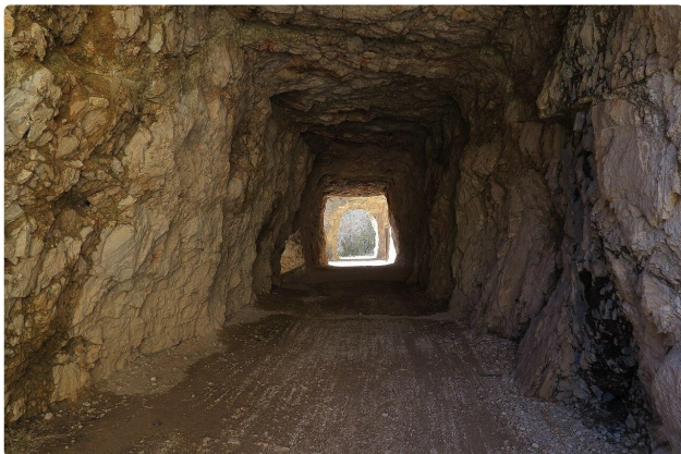
Tunel wykuty w skale przy Cuchillos, na końcu Camino de la Fonseca Fot. Malopez 21, CC BY-SA 4.0, Wikimedia Commons
